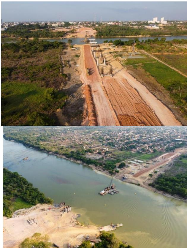
Obra estratégica para ampliar a mobilidade no município de Marabá, no sudeste paraense, a terceira ponte sobre o Rio Itacaiúnas chega a 20% de conclusão, avançando para a fase de concretagem dos pilares, estacas e travessas. A ponte, com 525 metros de extensão e 12 m de largura, é resultado de convênio do governo do Estado com a prefeitura de Marabá, superior a R\$ 100 milhões.
